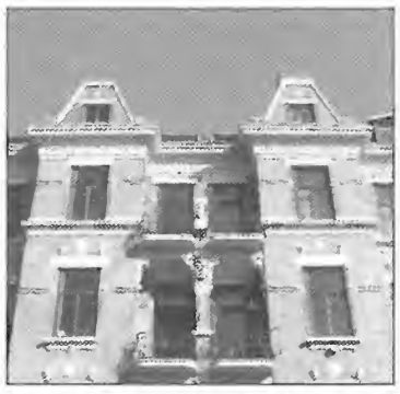
Vom Keller bis zum Dach: Gefahr durch Chlorprodukte lauert überall.
